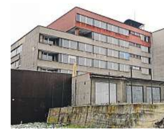
Hotelový dům Jindřich Objekt v Ostravě je v dezolátním stavu. Investor jej chce zbořit a na jeho místě postavit nový, moderní komplex.
